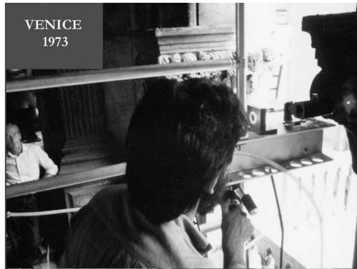
Fig.8. G. Calcagno laser-cleaning a Palazzo Ducale capital.
